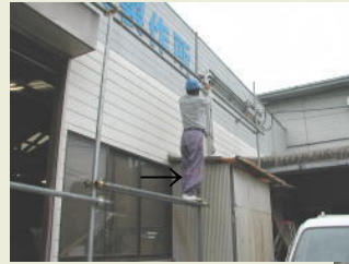
2 足場架設状況
