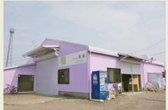
● 塗装工場外観
